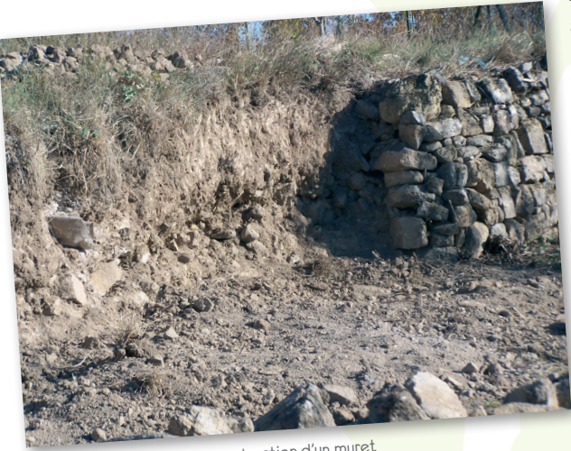
Construction d'un muret
